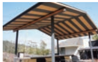
屋根の梁・柱
