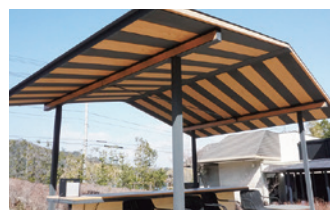
屋根の梁・柱
