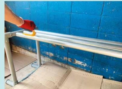
①単管パイプを塗装しています。単管パイプを塗装することによって単管パイプの防錆にもなります。
