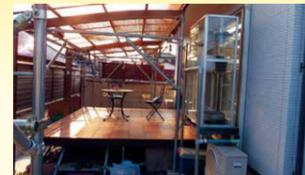
ウッドデッキにカーポートを設置。片屋根なので積雪対策のため、パイプで支えを張り巡らしています。物干し竿をパイプに取り付け、雨でも洗濯物が干せるようにしています。
