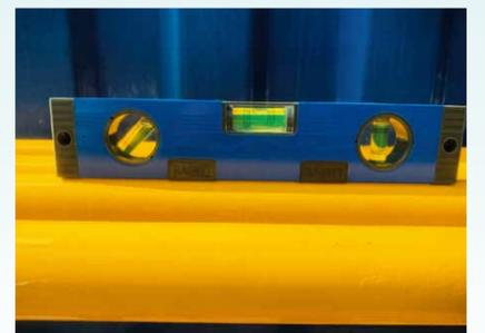
⑨水平ベンチ。最後に仮止めした所をしっかりと本止めを行い、完成です。写真では斜面にベンチを設置していますが、水平調整を行うことにより、水平になりました。
